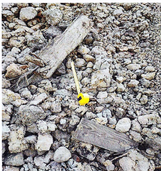
Obr. 3 a 4: Výskyt hořlavých materiálů v konstrukci oddělovací vzdušné stěny (M 30cm)
