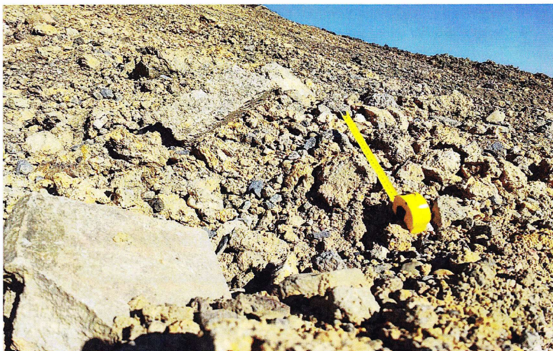
Obr. 9: Recyklovaná zemina roztažená na jihovýchodní svah střední části odvalu jako sanační materiál (v rozporu s projektem). Frakce neodpovídá certifikátu 0-90mm (M 30cm)
