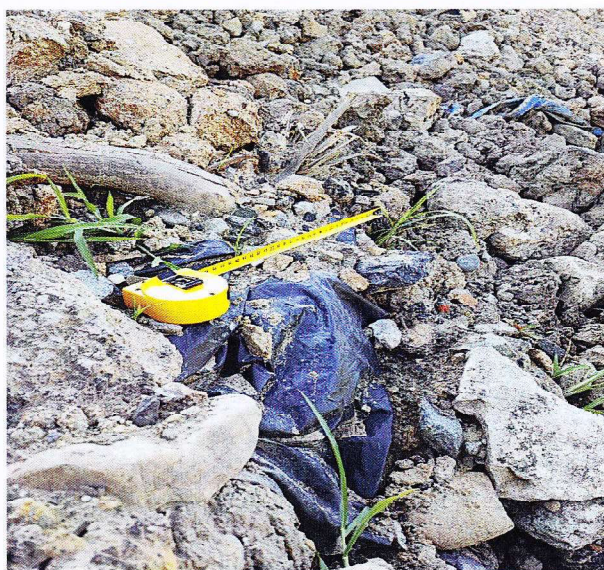
Obr. 3 a 4: Výskyt hořlavých materiálů v konstrukci oddělovací vzdušné stěny (M 30cm)
