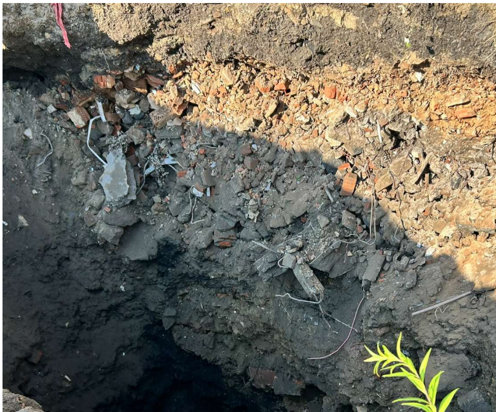
Obrázek 23 Charakter stavební sutě ve stěně KS
