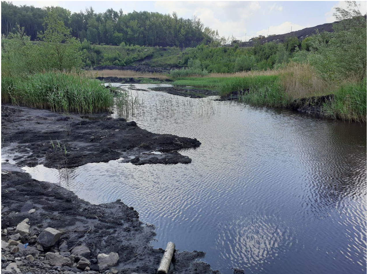
Obrázek 1: Odkalovací nádrž K-1 (jižní část)
