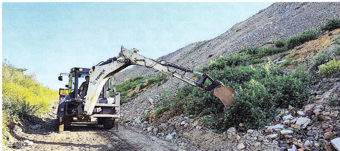
Obr. 1: Zahájení realizace kopané sondy
