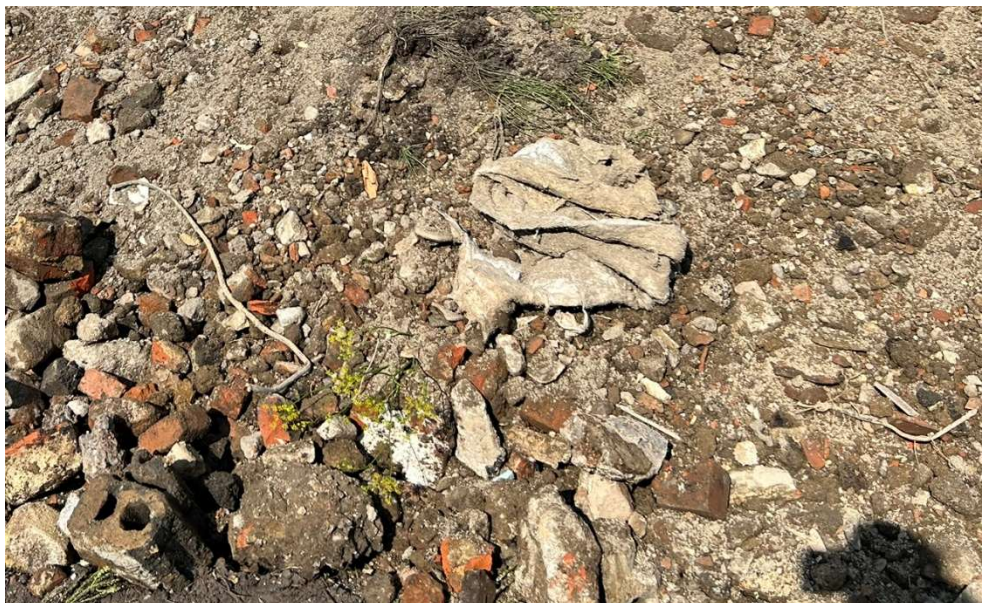
Obrázek 17 Dráty a geotextilie ve stavební suti v KS3
