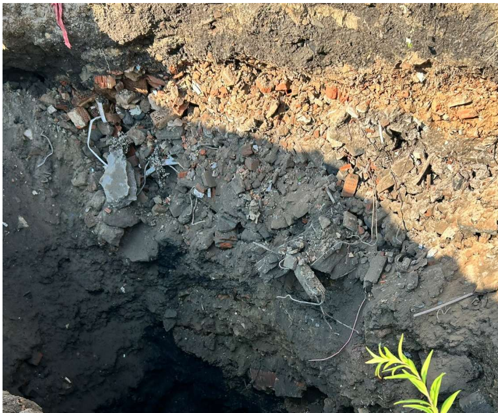
Obrázek 23 Charakter stavební sutě ve stěně KS
